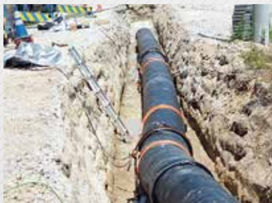
配管工事(ポリエチレンパイプ)
