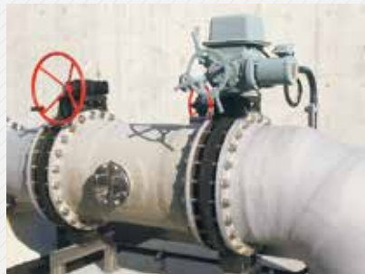
海水ライン(大口径バタフライ弁)
