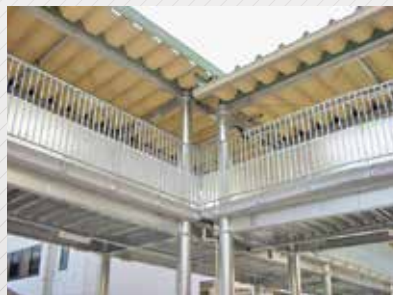
渡り廊下(ポリカーボネート)
