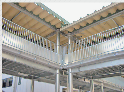
渡り廊下(ポリカーボネート)
