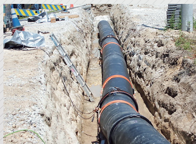
配管工事(ポリエチレンパイプ)
