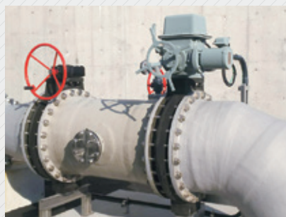
海水ライン(大口径バタフライ弁)
