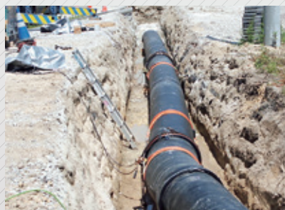
配管工事(ポリエチレンパイプ)
