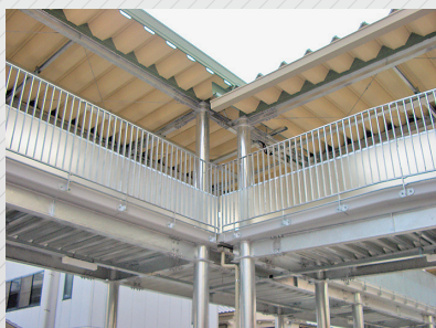
渡り廊下(ポリカーボネート)
