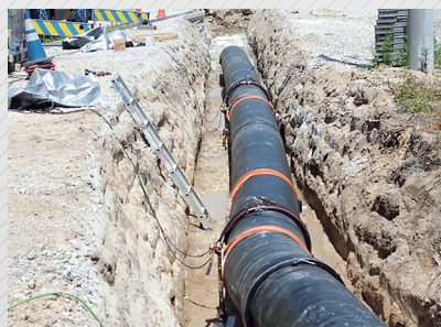
配管工事(ポリエチレンパイプ)
