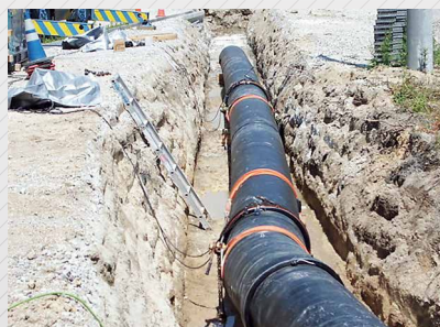
配管工事(ポリエチレンパイプ)
