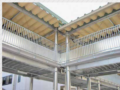
渡り廊下(ポリカーボネート)
