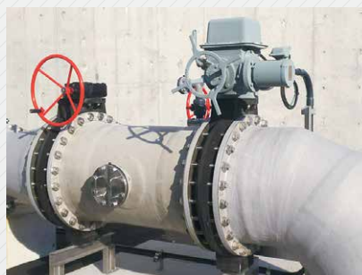
海水ライン(大口径バタフライ弁)
